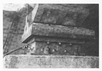
Bild 2. Kraftmesselement unter einem festen Brückenwiderlager eingebaut
