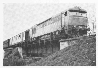
Die restlichen 50,5% werden durch die Auflager übertragen. Erwartungsgemäss übernehmen die beweglichen Auflager nur einen geringen Teil, welcher durch die vorhandene Rollenreibung bestimmt wird. Die festgestellten Reibungsverhältnisse der Rollen liegen im Rahmen der üblicherweise angenommenen Werte. Die Schienen übernehmen beim beweglichen Lager einen entsprechend grösseren Anteil der Bremskräfte.
