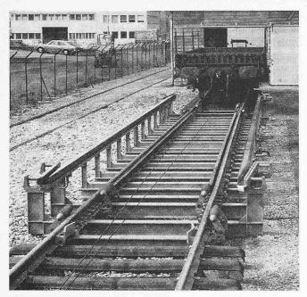
Bild 5. Automatische Umspuranlage im Werk in Villeneuve
