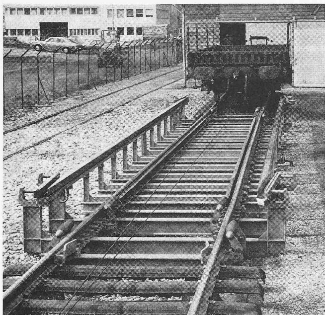
Bild 5. Automatische Umspuranlage im Werk in Villeneuve
