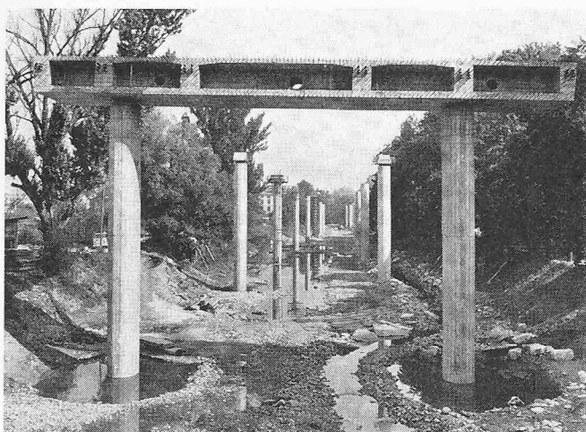
Bild 2. Im Flussbett der Sihl erstellte Hochstrassenpfeiler
