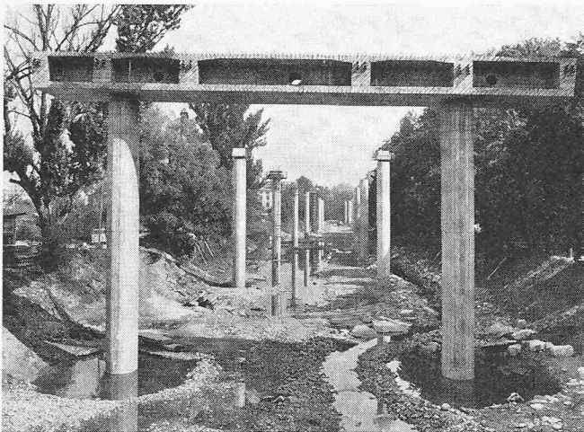
Bild 2. Im Flussbett der Sihl erstellte Hochstrassenpfeiler
