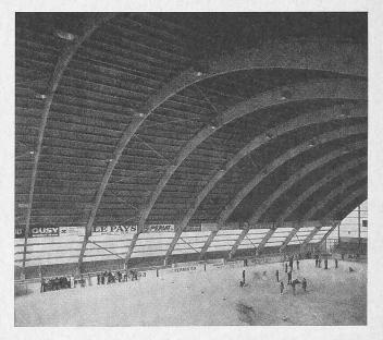
und Gewicht, können mit dem Baustoff Holz in Form von Lamellenbindern oder Fachwerkträgern grosse Spannweiten stützenfrei überbrückt werden.
