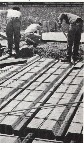
Dieses vorfabrizierte, ab Lager lieferbare Elementsystem eignet sich im Hochbau besonders für Hohlraum- und Kellerdecken. Die vorgespannten Betonbalken und die Tonhourdis übernehmen die Funktionen der Deckenschalung und der Hauptarmierung.
