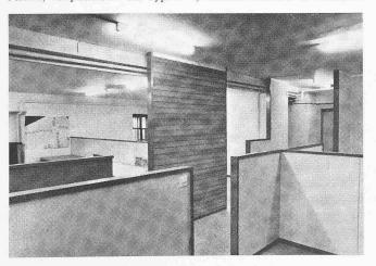
Bei der konstruktiven Durchbildung muss den verhältnismässig grossen Schwind- und Quellenbewegungen Rechnung getragen werden.
