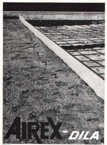
Fugen Brückenanschluss Nationalstrasse N 1 elnlage
