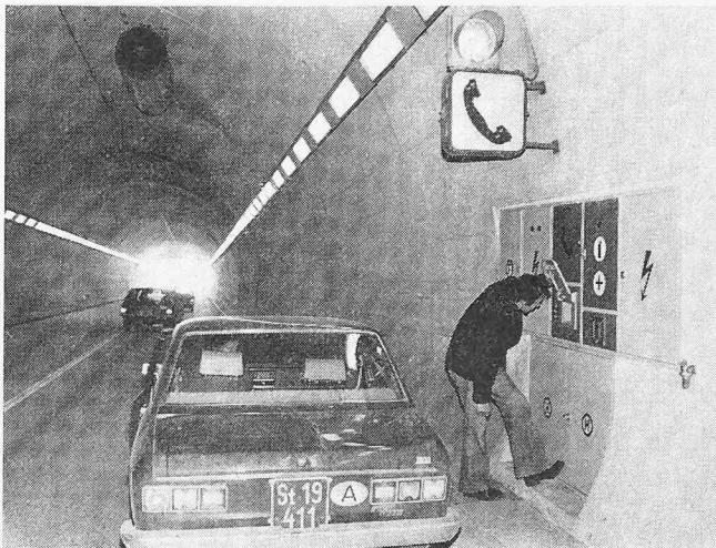
Nur für die Feuerwehr zugänglich sind dagegen die in den Nischen untergebrachten Feuerlöscheinrichtungen. Die Länge der Schläuche erlaubt es, von zwei Seiten an ein brennendes Fahrzeug heranzugehen. Die Wasserversorgungsanlage steht ständig unter einem Betriebsdruck von 10 atü. Im Winter sind die Wasserzuführungen elektrisch beheizt.
