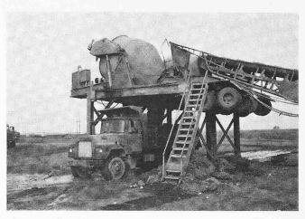
Bild 11. Diese Mischer laden abwechselnd die Betontransportwagen, welche je 10 cu yards (7,7 m³) fassen. Die Transportbänder bringen das Material zu den Mischern, welche automatisch in richtiger Reihenfolge die Transport-«Trucks» beladen
