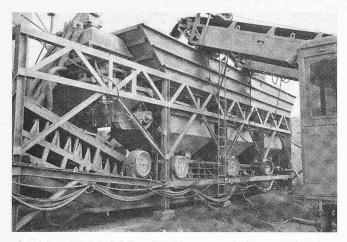
Bild 10. Der Zementmischer. Die Vorratswanne oben und die Wiegeschüttler (Hüpfer) unten mit den runden Skalen dosieren den Zement, zwei Grössen von Steinen und Sand. Wahlweise kann sehr rasch auf die nötige Mischung umgestellt werden. Der Steuerteil ist in dem auf der rechten Seite gerade noch sichtbaren Wagen untergebracht
