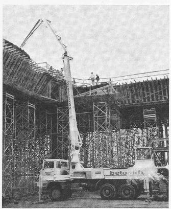
Die neueren Modelle sind meistens auf Fahrzeugen und Anhängern installiert. Ihre Leistungsfähigkeit wird durch einen drehbaren, hydraulisch gelenkten Ausleger, an dem die Förderleitung montiert ist, erhöht. Die Reichweite variert je nach Modell bei gestreckter Armlänge zwischen 15 und 20 m horizontal, 20 und 30 m vertikal und einer Tiefe (ohne Endschlauch) von 7 bis 8 m.
