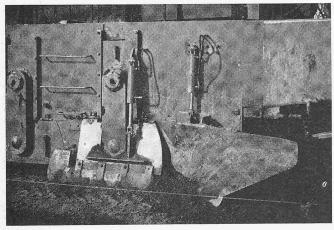
Bild 2. Das bei der Ausgleichsverteilung überflüssige Untergrundmaterial wird von der Maschine nach dem Strassenrand abgeschoben
