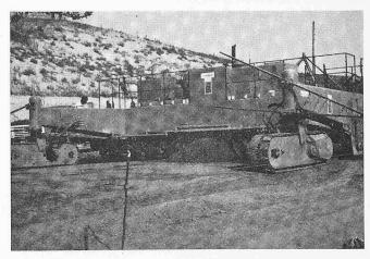
Bild 1. Betonstrassenbaumaschine bei der Ausgleichsverteilung des Unterbaumaterials. Automatisch gesteuert und geführt von einem Nylonseil, das mit 100 kg Zug gespannt etwa alle 150 m gestützt ist
