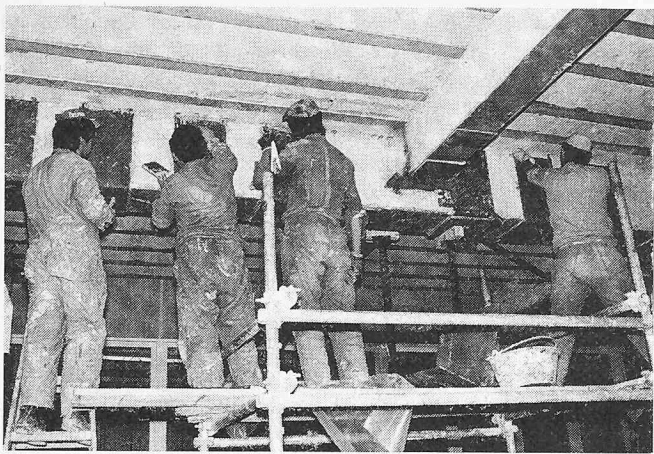
Bild 30. Montage der Schubleche an den Hauptunterzügen
