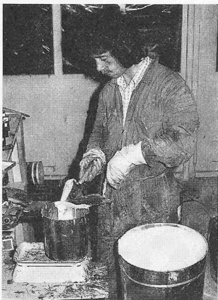
Bild 35. Abwägen der Harzkomponente der Klebmasse
