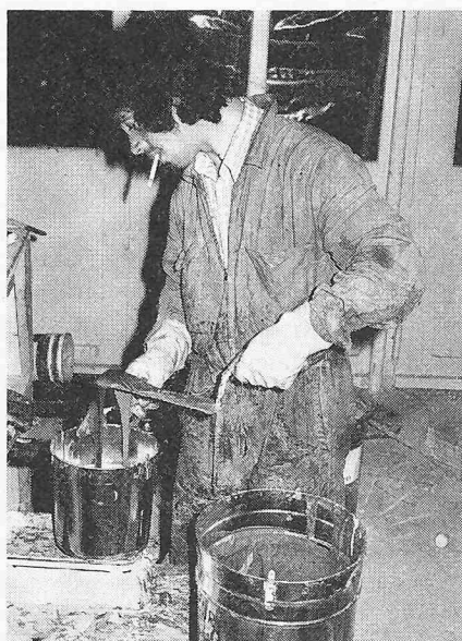
Bild 36. Abwägen der Härterkomponente der Klebmasse
