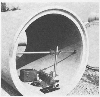
In der Schweiz sind über 250 solche Geräte im Einsatz. Der Ausnützungsgrad der Tunnelbohrmaschinen konnte mit Hilfe der Laser-Richtgeräte um 1 bis 2 h/Tag gesteigert werden. Im Kanalbau ergaben sich sogar Steigerungen von mehr als 30 %.
