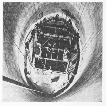
Colebrand Organisation, eigens der Werkstoff CXL 2000 entwickelt. Der Arbeitsumfang umfasst die Vorbehandlung der Flächen sowie das Auf bringen der Spritzbeschichtung auf eine Fläche, die sich vom Kamineinlauf am Boiler in 31 m Höhe über dem Erdboden bis in 245 m Höhe, d. h. über eine Gesamtfläche von rund 7500 m², erstreckt.
