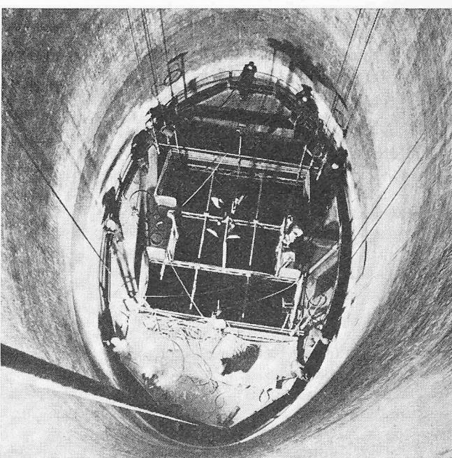
Colebrand Organisation, eigens der Werkstoff CXL 2000 entwickelt. Der Arbeitsumfang umfasst die Vorbehandlung der Flächen sowie das Aufbringen der Spritzbeschichtung auf eine Fläche, die sich vom Kamineinlauf am Boiler in 31 m Höhe über dem Erdboden bis in 245 m Höhe, d. h. über eine Gesamtfläche von rund 7500 m<sup>2</sup>, erstreckt.
