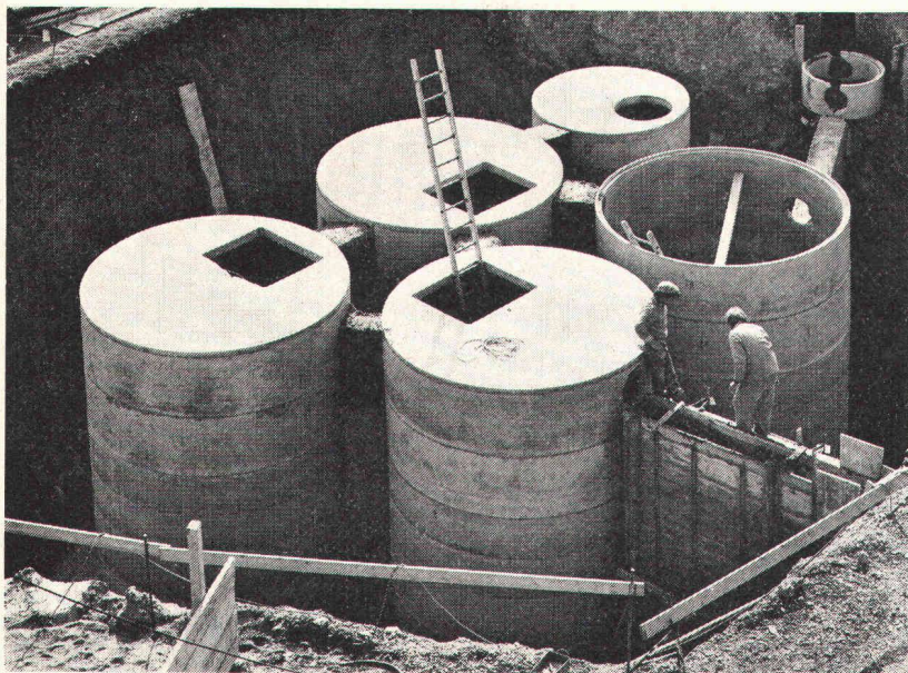
Einbau einer biologischen Kläranlage im Kanton Schaffhausen
