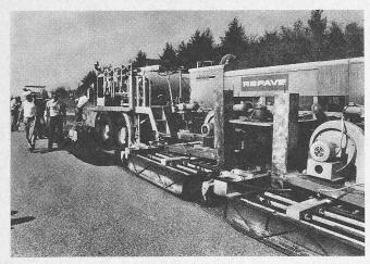
Das «Repave»-System ist erstmals in Europa auf der N1 eingesetzt worden. Es saniert schadhafte bituminöse Deckbeläge in einem Durchgang
