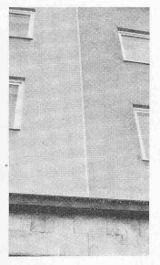
Innenfugen werden je nach Anforderung entweder wasserdicht oder nur mit einer aus ästhetischen Gründen erforderlichen Fugenabdeckung versehen. Bei Fassaden mit Verputzschichten muss je nach Fugenspiel zur Aufnahme der Spannungen, Dehnungen, Schrumpfungen und Setzungen, zur Verhinderung der sonst auftretenden Risse ebenfalls eine elastische bewegliche Übergangskonstruktion eingebaut werden. Dabei ist ein fachgerechter Anschluss des Verputzes an die Randwinkel und den Untergrund wichtig.
