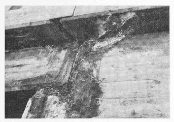
Bild 3. Beschädigung eines Brückenwiderlagers infolge undichten Fahrbahnüberganges
