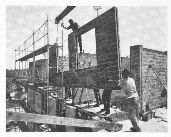
Bild 4. Montage eines Fassadenelementes im 17. Stock und Ansicht der Betonplatten des 16. Stockes
