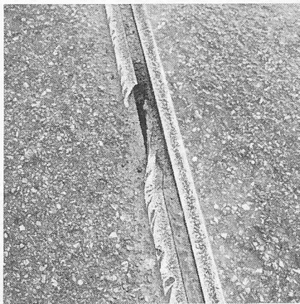
Bild 6. Beschädigte Übergangs-Randprofile in einer Brückenfahrbahn. Zu hoch verlegte Randprofile boten dem Schneepflug Angriffsflächen
