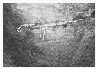
Bild 4. Kalkausblühungen in einer Parkgarage infolge undichter Fuge
