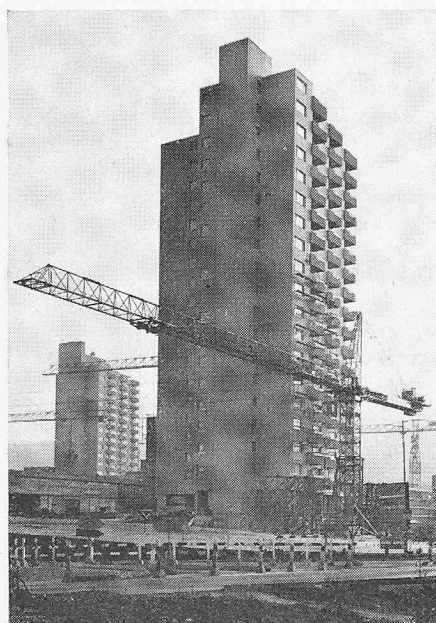
Bild 3, rechts. Anlieferung der Preton- und Betontafeln im Takt mit der Montage
