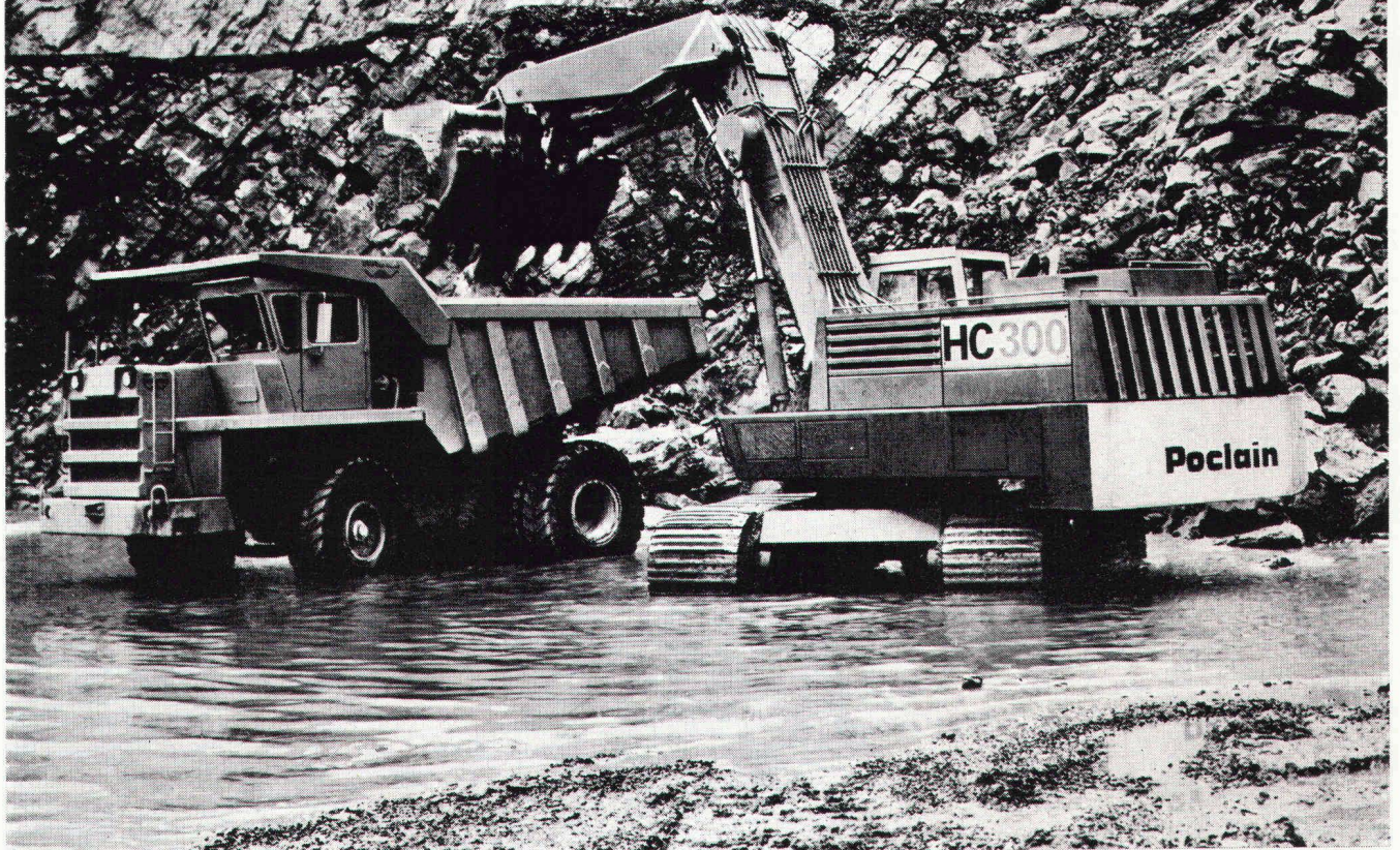
POCLAIN Hydrobagger Mod. HC 300 und WABCO Muldenkipper «Haulpak» mit 35 t Nutzlast
