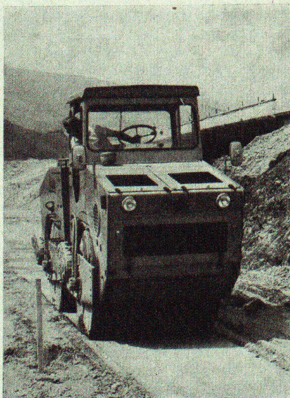
Die knickgelenkte Clark-Scheid-Doppelvibrationswalze DV 100
