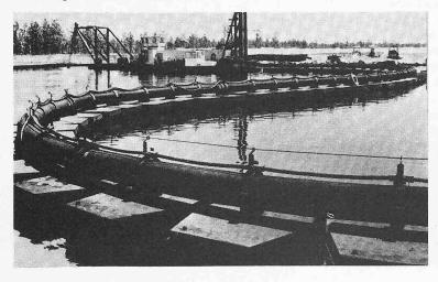
Bild 3. Die 250 m lange Rohrleitung zwischen einem Saugbagger (links) und der Aufbereitungsanlage (rechts) – auf dem Wasser wie eine Seeschlange schwimmend
