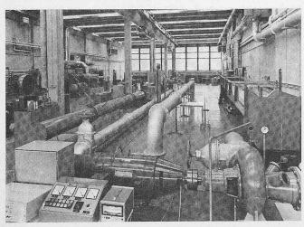
Bild 3. Labor für Hydraulik: Studenten des 5. Semesters eichen einen Kanalventuri und eine Überfallschwelle für verschiedene stationäre Abflussgrössen
