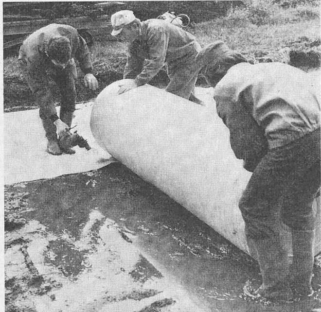
und für den Gleisunterbau eingesetzt. Die elastischen Dichtungsbahnen überbrücken selbst grössere und plötzlich entstehende Risse in der Unterkonstruktion. Sie können auch auf nassen Flächen verlegt werden. Im Wasserbau liegen die Einsatzmöglichkeiten im Deich- und Dammbau sowie bei der Sicherung von Ufern und Böschungen. Die Verfestigung ist froststabil. Selbst staubende Halden und Müllablagen lassen sich mit diesem Material wirksam binden.
