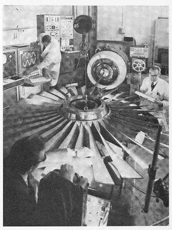
Bild 13. Ein Bläser wird statischen Schwingungsprüfungen unterzogen. Kontrolliert werden die Schwingungsphasenbeziehungen zwischen den Schaufeln mit Hilfe eines Oszilloskops (hinten). Mit einem Stroboskop (vorne) werden visuelle Beobachtungen ermöglicht
