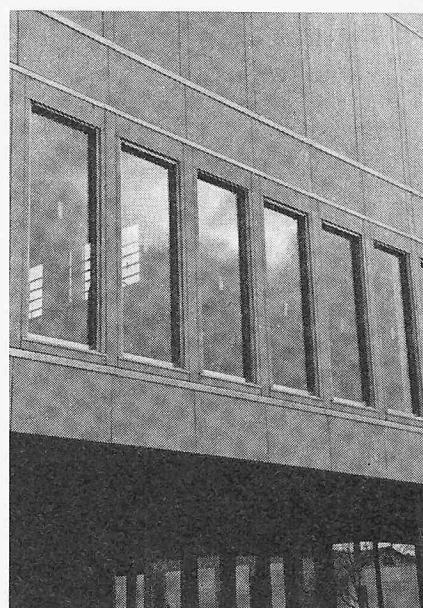
Bild der fertigen Aussenwand
