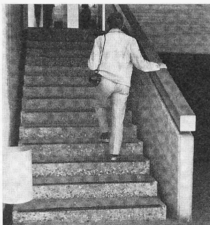
Bilder 5 und 6. Der Handlauf rechts ist überdimensioniert, so dass man sich daran mit einer Hand nicht festhalten kann. Und wand-
