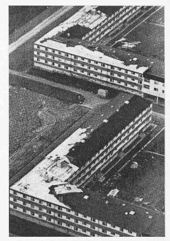
Bild 11. Typische Schäden, Anströmung über die linke Hausecke
