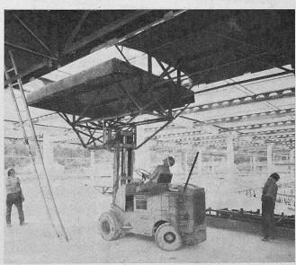
dass die Stege der Träger und Unterzüge zugleich mit der Deckenplatte einbetoniert werden. Das Einbetonieren der Träger ist mit folgenden Vorteilen verbunden:
