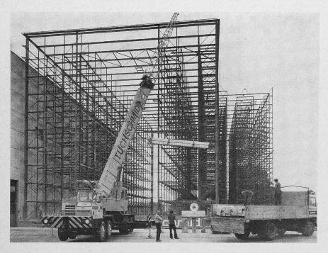
Bild 1. Stirnseitige Ansicht des Hochregallagers in Zuchwil während der Montage. Links Webmaschinenlager, rechts Palettenlager
