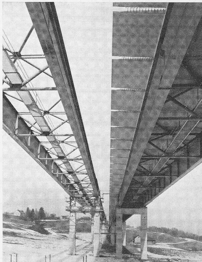
Viaduc du Bergbach près de St-Gall, N. 1 St-Gall-St-Margrethen. Deux ponts parallèles. Portées: 70,0+4 \times 77,5+60,0 m. Dalle en éléments préfabriqués en usine, sans précontrainte, et mis en place à l'aide d'un engin spécial. (Voir H. Kunz et H. Kapp : Der Bergbach-viadukt. «Schweizerische Bauzeitung» No 41 du 11 octobre 1973, p. 987-992)
