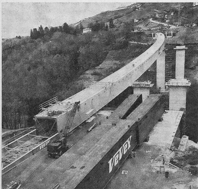
Ponts sur la Veveyse au-dessus de Vevey, N. 9 Autoroute du Léman. Deux ponts parallèles, en courbe, R = 900 m. Portées: 111+129+58 m. Par pont: une poutre métallique, en caisson quasi rectangulaire de 6 \times 5 m. Dalles coulées sur place sur coffrages mobiles et précontraintes transversalement. (Voir P. Preisig : Die Autobahnbrücke über die Veveyse. «Schweizerische Bauzeitung» No 18 du 1er mai 1969, p. 340 à 341)
