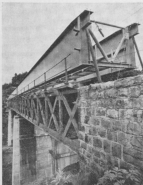
Pont CFF sur la Mionnaz près de Palézieux, ligne de chemin de fer Lausanne-Berne. Remplacement d'un ancien pont métallique rivé, à treillis, par un nouveau pont en construction mixte avec poutres métalliques en \text{I} et auge en béton armé supportant le ballast de la voie. La construction métallique a été d'abord montée au-dessus de l'ancien pont avant destruction de celui-ci. L'auge est formée d'éléments préfabriqués en usine, et précontraints longitudinalement après pose, par câbles et par abaissement des poutres sur piles. Portées: 34+43+34 m
