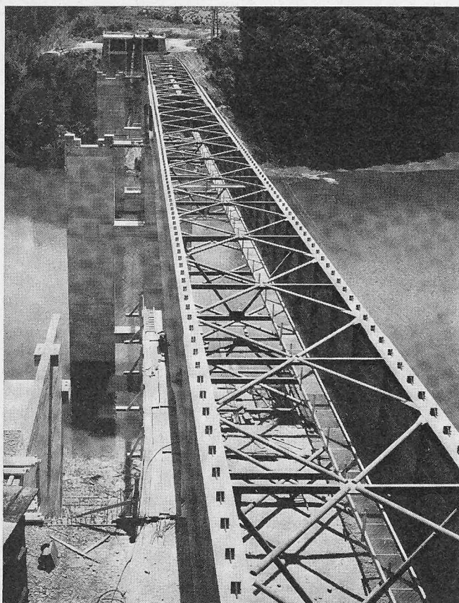
Ponts sur la Sarine. Route Nationale 12 Fribourg-Berne. Deux ponts parallèles, soit un pour chaque sens de circulation. Portées: 85,5+106,5+85,5 m. Piles construites avant le remplissage du lac de la retenue de Schiffenen. Précontrainte longitudinale sur appuis par câbles et par abaïssement. (Voir P. Dubas und H. Hauri : Die Autobahnbrücke über die Saane bei Fribourg. «Schweizerische Bauzeitung» No 1 du 6 janvier 1966, p. 8-20)
