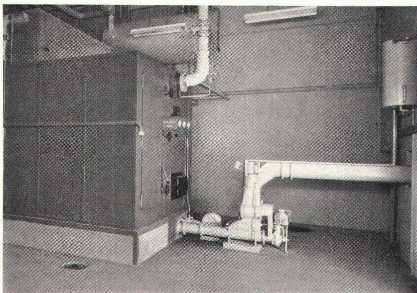
Vollständig geschlossene mechanische Anlagen, mit Tagesbunker oder automatischer Siloaustragung mit stufenloser Leistungsregulierung.
