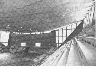
Innenansicht an Längswand und Diagonalfenster. Rechter Hand die aufgehenden Binder mit der Tribünenanlage. Untersicht an Hängedach aus Leca-Beton von 7,5 cm Stärke
