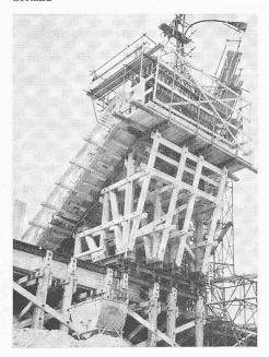
Bild 2. Bauvorgang Hängedach: Betonieretappe von 10 m Breite des Hängedaches aus Leca-Beton, auf einem verschiebbaren Gerüst eingeschalt. Rechts im Bild der aus herkömmlichem Beton vorweg erstellte Dachkranz, links oben der in Dachmitte angeordnete Dilatationsträger
