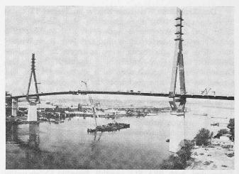
Einheben des vorletzten Brückenteiles der Mittelöffnung durch einen Schwimmkran (Werkphoto Rheinstahl AG)
