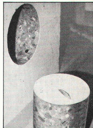
Millimetergenaues Bohrloch mit Bohrkern. Zuputzarbeit erübrigt sich.
