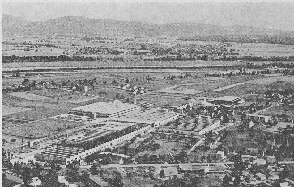
Luftaufnahme der Fabrikationsanlage der Jansen AG in Oberriet
