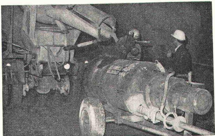
Betonpumpe Spiroret zum Fördern
