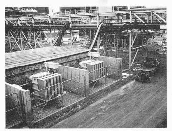
Bild 4. Transformatorenverteilstation mit Kabelverlegung auf Rohrbrücken
