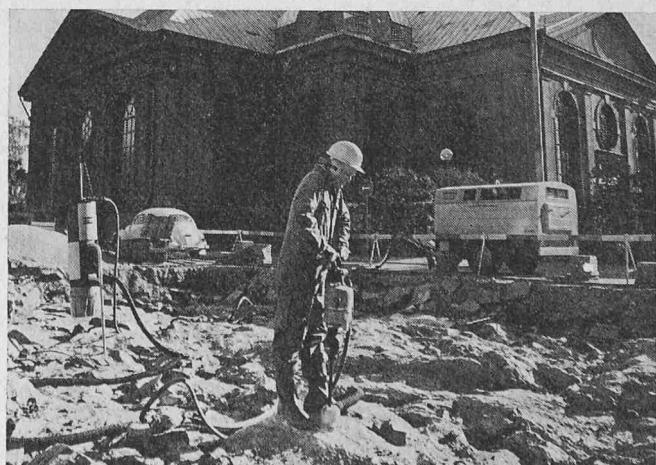
Das Staubproblem war hauptsächlich bei handgehaltenen Bohrhämmern akut, wo ein Arbeiter nur ungenügend Distanz zur Bohrstelle innehalten kann. Mit dem DCT-Gerät, das mit einem Stab in ein Bohrloch gesteckt wird, hat der Bedienungsmann einen Arbeitsradius von 10 Metern und kann in völlig staubfreier Luft die ganze Bohrarbeit verrichten, wobei er lediglich Saugschlauch und Haube von einem Bohrloch zum andern verlegen muss.
