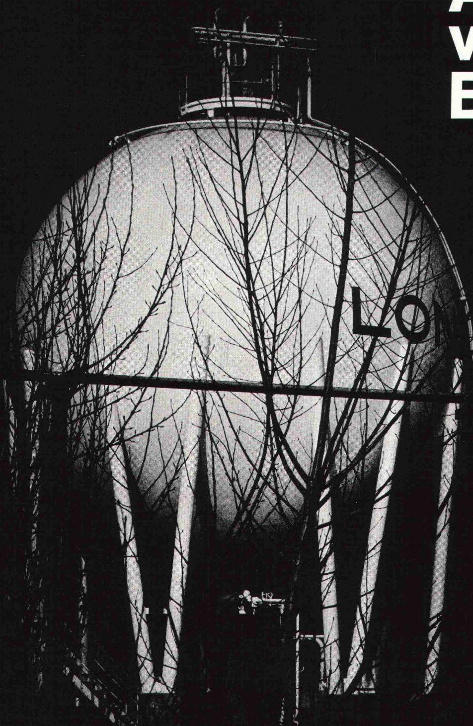
Hochwertige Werkstoffe, besonders entwickelte Schweißverfahren und neuzeitliche, zerstörungsfreie Prüfmethoden ermöglichen den Bau grosser Kugelbehälter für Stadtgas und Flüssiggase. Buss AG, Basel
