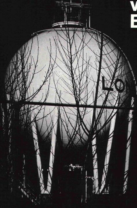
Hochwertige Werkstoffe, besonders entwickelte Schweissverfahren und neuzeitliche, zerstörungsfreie Prüfmethoden ermöglichen den Bau grosser Kugelbehälter für Stadtgas und Flüssiggase. Buss AG, Basel
