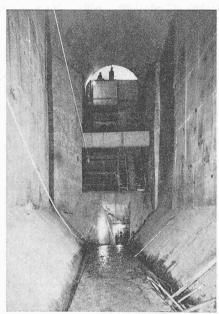
Bild 29 (links aussen). Anfang der 500 m langen und 8 m breiten Pulmónkammer des Kraftwerks Matucana
