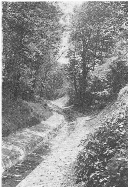
Bild 4. Korrektur des Altstätter Stadtbaches. Gepflasterte Niederwasserrinne. Der alte, schöne Baumbestand wurde bei den Arbeiten geschützt und blieb erhalten. Melioration der Rheinebene
