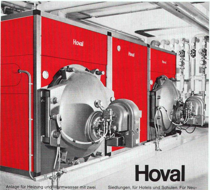
Anlage für Heizung und Warmwasser mit zwei Hoval-Hochleistungskesseln Typ TKD-R, Modul-Boiler zwischen den Kesseln.
