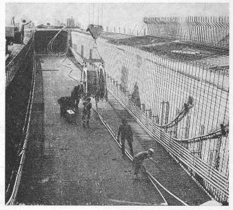
Bild 6. Kabelverlegung, rechts: vorfabrizierte Wandarmierungsnetze
