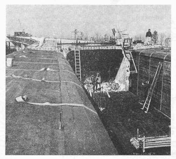
Bild 5. Oberbauschalung, Abdeckung der Fugen mit Plastikbändern
