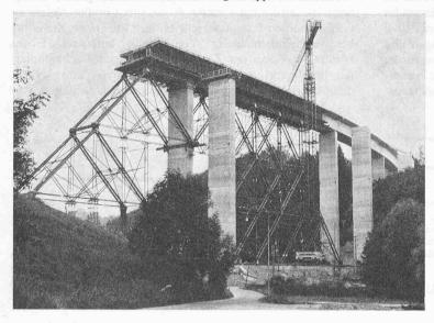
Bild 2. Gerüstung und Schalung für die 60 m lange Schlussetappe zwischen Pfeiler D und E der Brücke II
