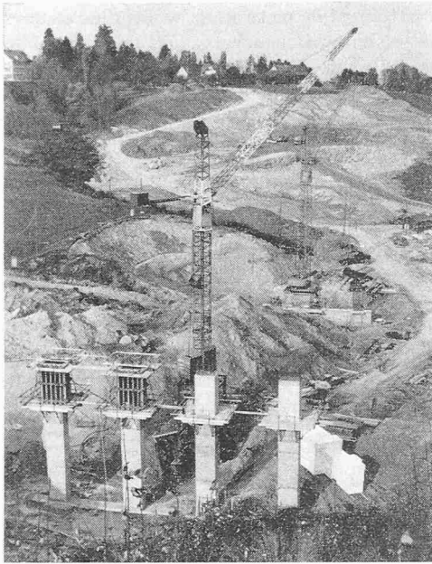
Bild 4. Baugrube für die Pfeiler C und D, Pfeilerschäfte C auf halber Höhe
