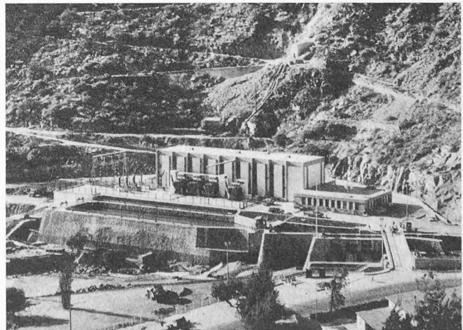
Bild 3. Zentrale Pablo Boner in Surco mit einer installierten Leistung von 120 MW. Davor die Fassung und die Entsanderanlage der älteren Ausbaustufe Callahuanca. Im Vordergrund die transandinische Strasse
