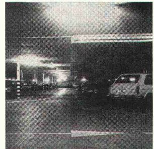
Salviacim-Belag im Parkhaus Bodmergut, Zürich
