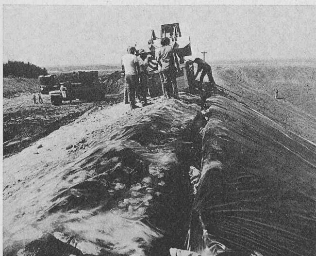
Der Synthesekautschuk von Du Pont ist beständig gegen die Einwirkung von Sonnenlicht, atmosphärisches Ozon und die zur Wasserbehandlung verwendeten Chemikalien. Er verleiht dem Wasser keinen Beigeschmack und erlaubt, an Ort und Stelle undurchlässige Materialverbindungen herzustellen. Die Verstärkung mit Nylongewebe erhöht die Kerbzähigkeit, vermindert ungewollte Dehnungen während des Verlegens und hält die Schrumpfung durch spätere Temperaturschwankungen gering.
