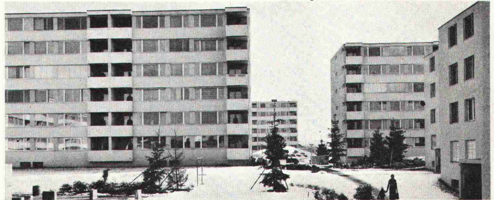
Überbauung Rain, Jona SG
