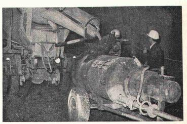
Betonpumpe Spirocret zum Fördern und Nassspritzen - die Pumpe mit der grossen Leistung
