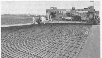
kel von 60° (vgl. Bilder 3 und 4). So fallen auftretende Querrisse nicht mehr in die Achse der Querbewehrung. Die Bewehrung wird entweder auf der Baustelle oder nach dem Einbau verbunden oder durch Elektroschweissung in Matten vorgefertigt.
