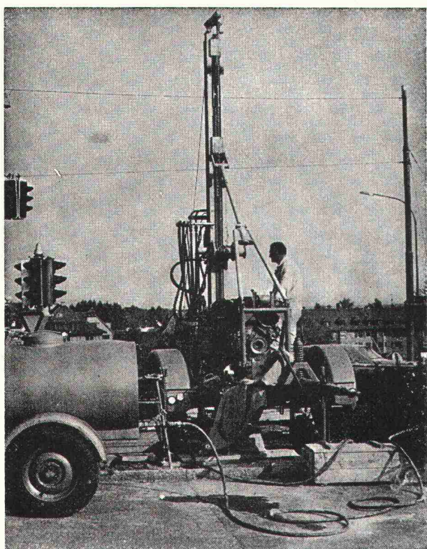
Sondierbohrung Bucheggplatz Zürich
