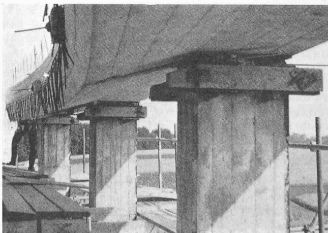
Bild 7. Hallenstützen mit fertig montierten Druckringelementen
