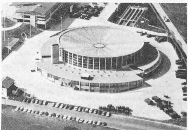
Bild 2. Flugaufnahme der Rundhalle mit Annexbauten
